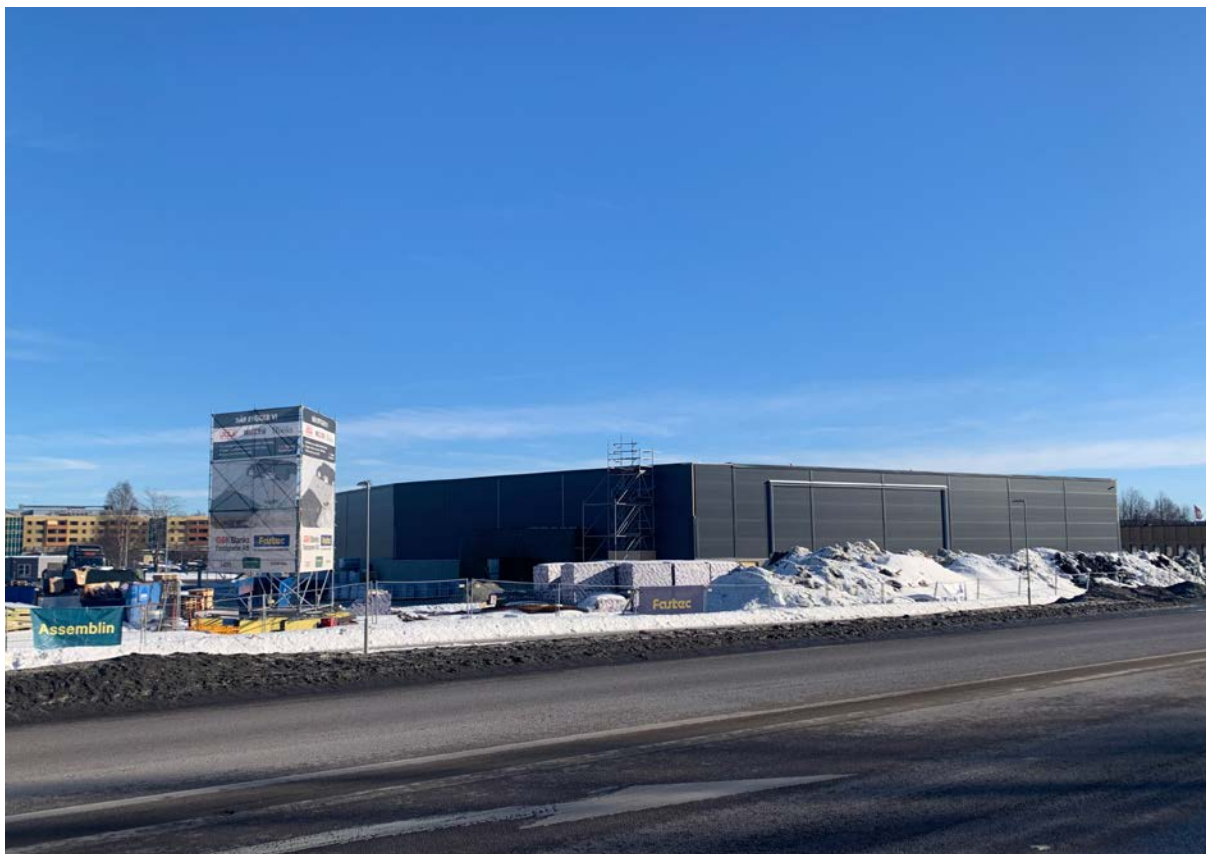
Pågående byggprojekt på Anderstorp, Skellefteå som färdigställs under 2022
